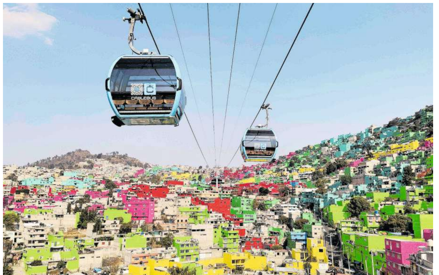
Die Garaventa-Angestellten waren in Mexico City mit Spezialwerkzeugen an der Arbeit, um die Seilbahn hoch über den Dächern der Grossstadt zu montieren.
