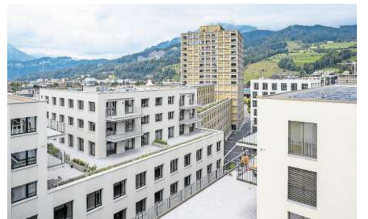
Die Baustelle Mattenhof in Kriens.
