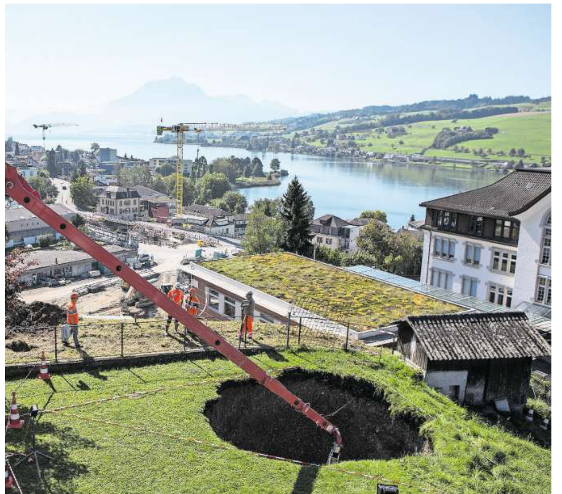
Glimpflich ausgegangen: Blick auf das Erdloch.
